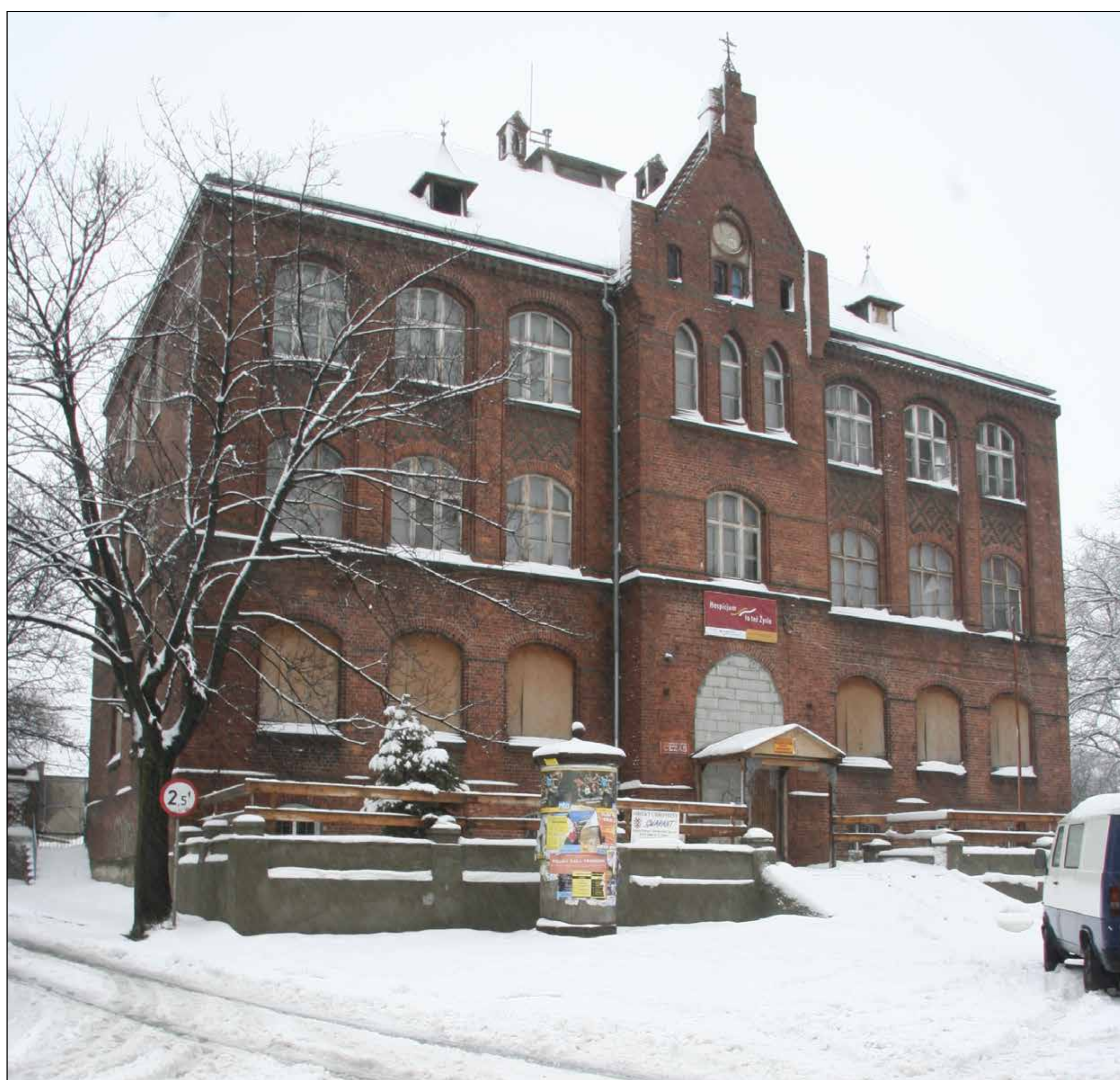
Budynek „starej” szkoły w trakcie przebudowy na Hospicjum, 2006 r.
