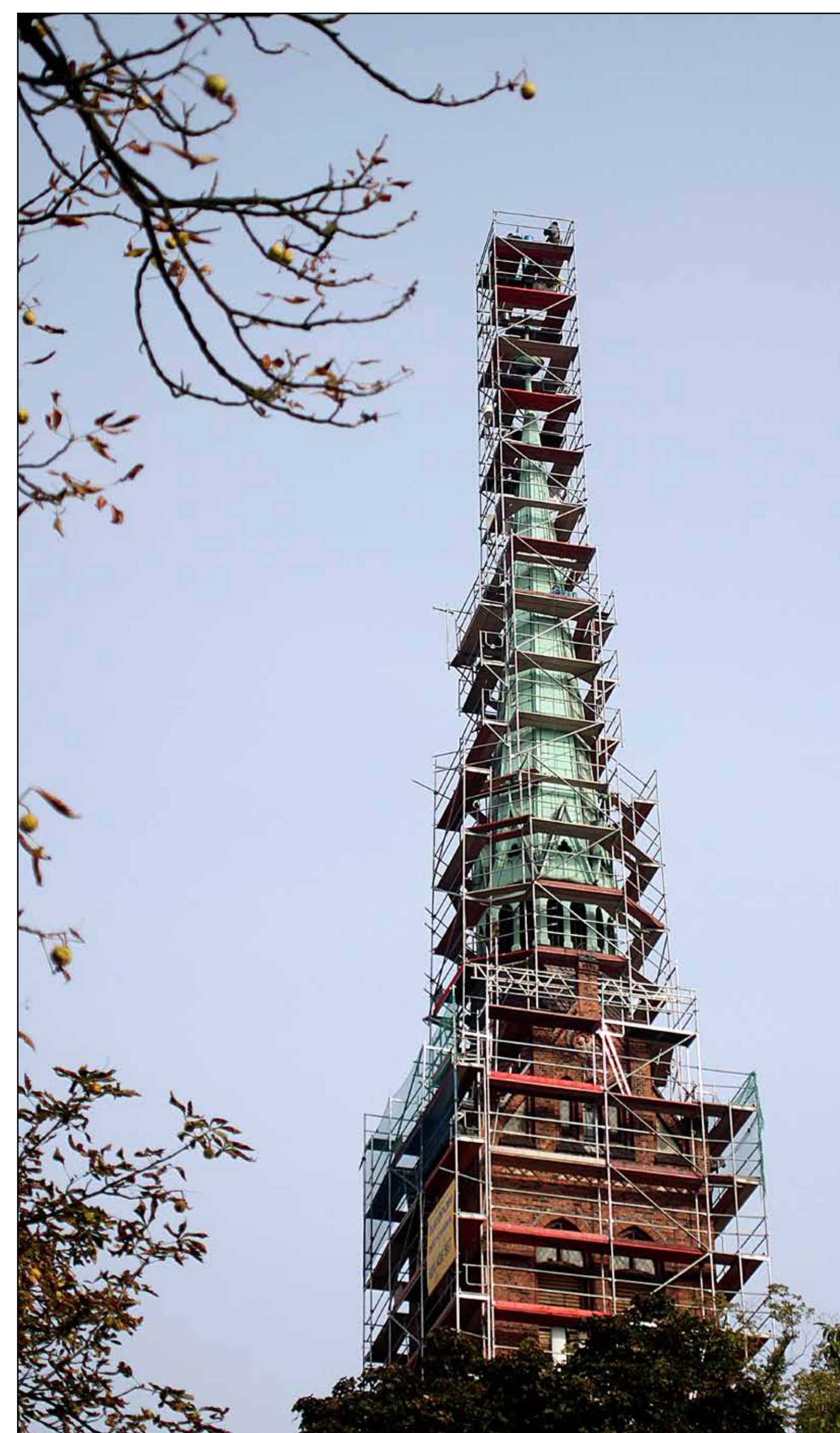
Remont wieży kościoła - montaż nowej iglicy, 2012 r.
